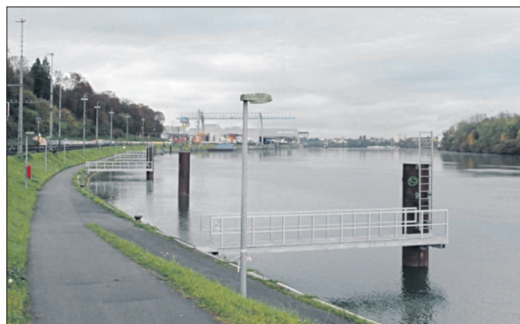
Neue Landestege für das Schiffpersonal und neue Dalbenschläge am Muttenzer Auhafen mit Blick auf den Birsfelder Hafen. Foto zVg
